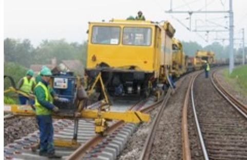
*Longs Rails soudés sur traverses béton*
